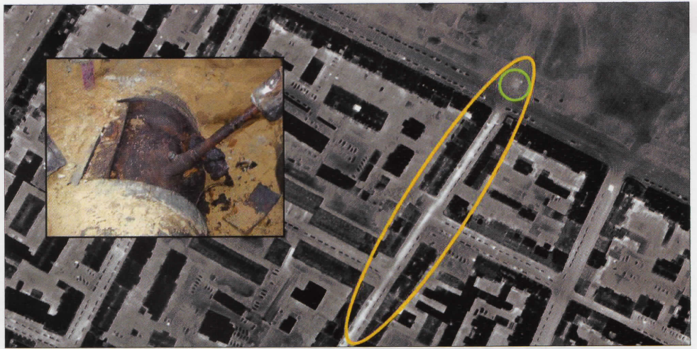
Bild 6. KMR-Trasse 2 x DN 400/560, Verlegejahr 1994, in der Dresdener Alaunstraße mit erhöhter Wärmeabstrahlung
